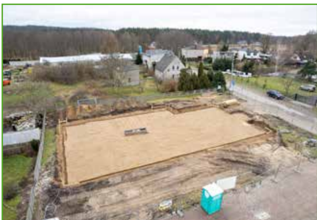
Plac budowy remizy w Bratianie
