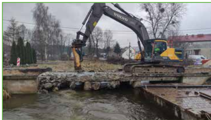
Most w trakcie rozbiórki
